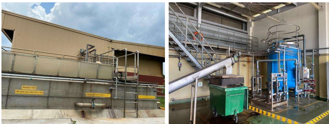
Hình 3.4: Hệ thống xử lý nước thải sinh hoạt 100 m³/ngày
