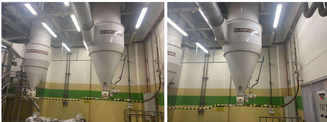
Hình 3.34: Hệ thống xử lý khí thải lò rang cà phê
