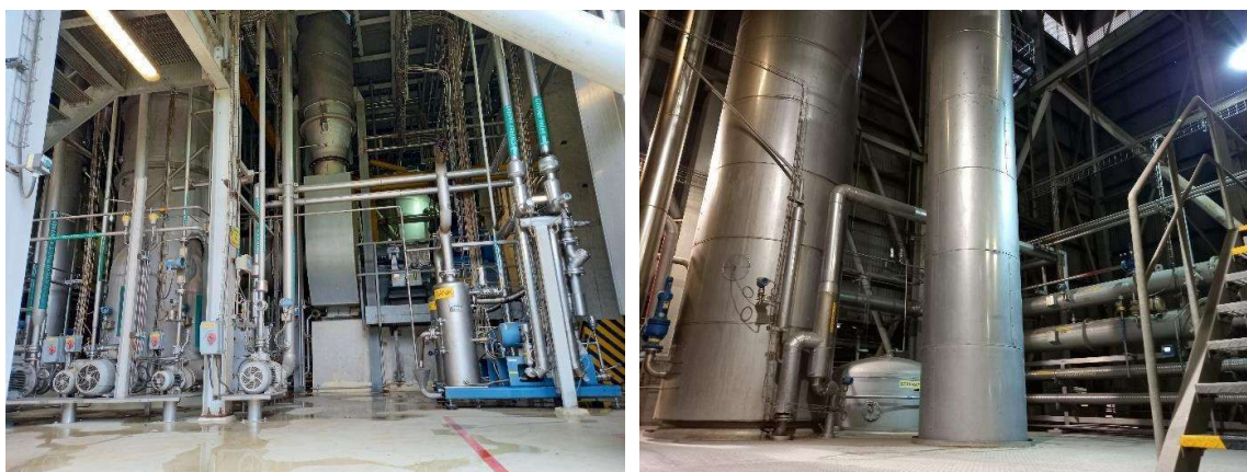
Hình 3.6: Hệ thống xử lý nước thải sản xuất có độ màu cao công suất 384 m 3 /ngày
