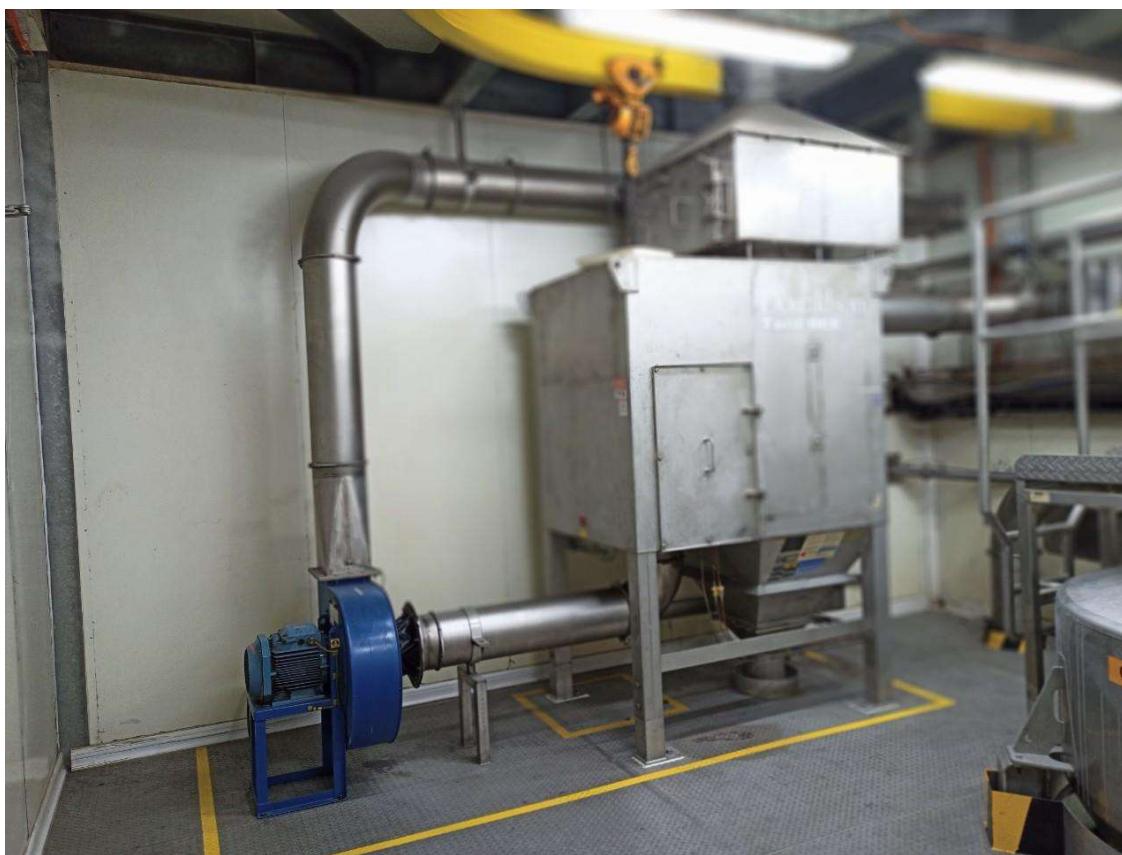
Hình 3.26: Hệ thống xử lý khí thải từ quy trình đóng gói cà phê in
