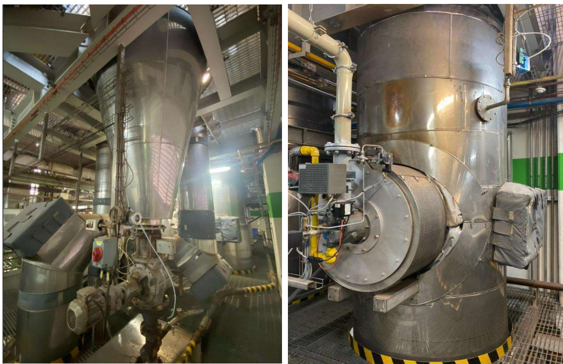
Hình 3.24: Hệ thống xử lý khí thải lò rang cà phê
