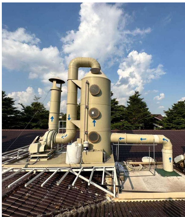
Hình 3.21: Hình ảnh HTXL khí thải hấp thụ bằng dung dịch H_2SO_4
