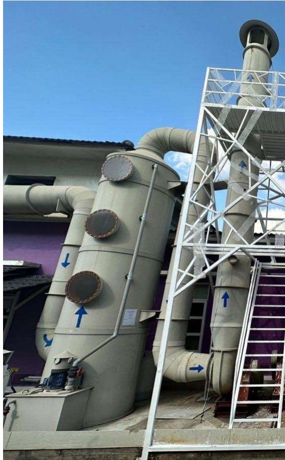
Hình 3.15: Hình ảnh HTXL khí thải hấp thụ bằng dung dịch H_2SO_4
