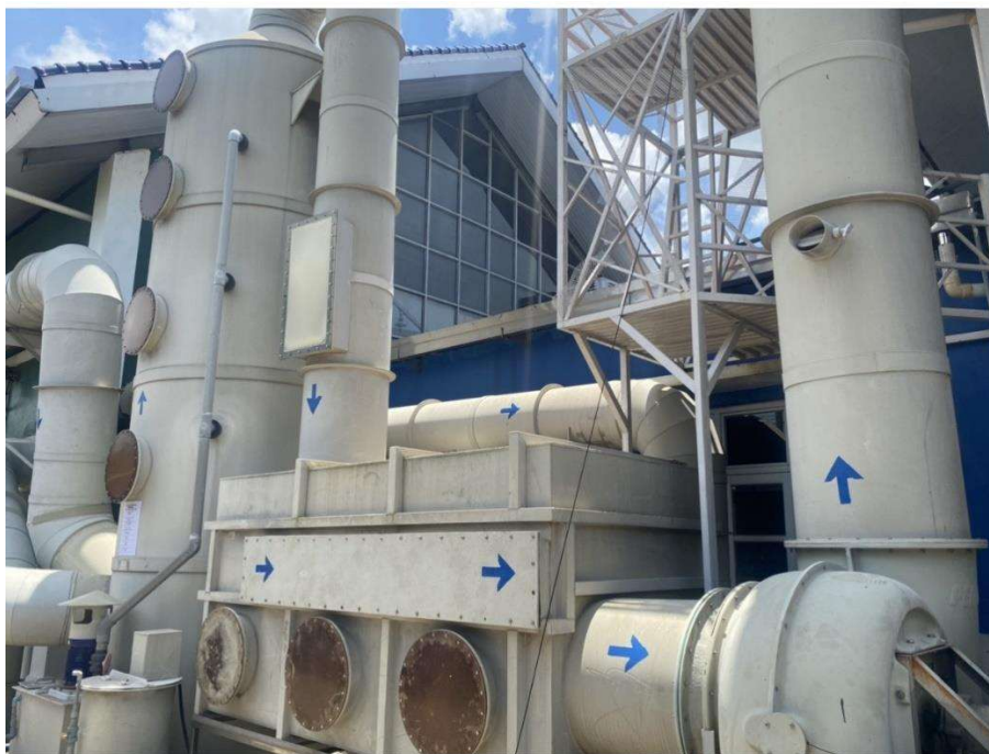
Hình 3.23: Hình ảnh HTXL khí thải sơn tĩnh điện
