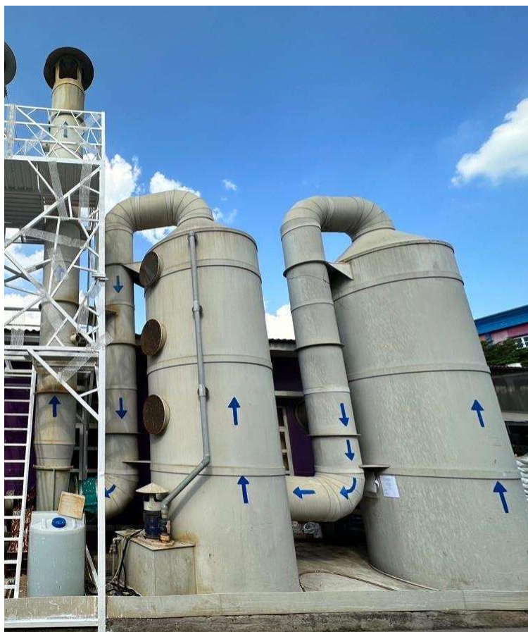
Hình 3.17: Hình ảnh HTXL khí thải hấp thụ bằng dung dịch NaOH
