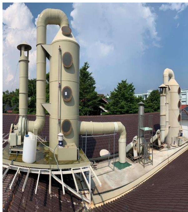
Hình 3.21: Hình ảnh HTXL khí thải hấp thụ bằng dung dịch H_2SO_4
