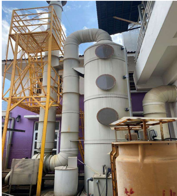
Hình 3.13: Hình ảnh HTXL hấp thụ bằng thụ nước
