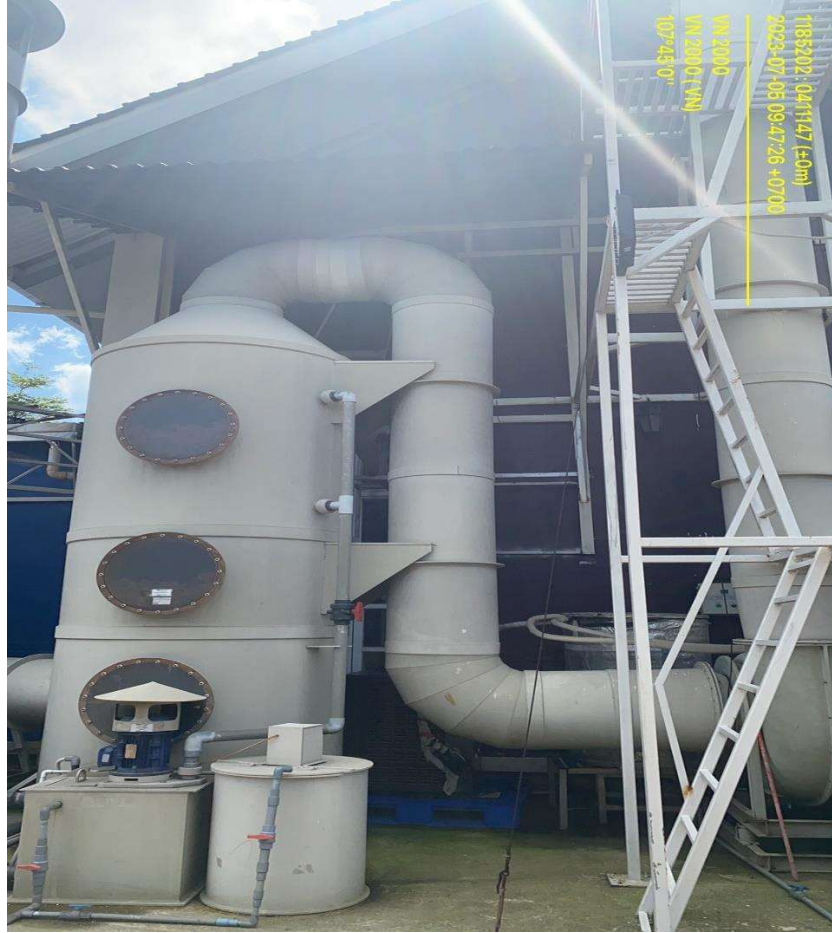
Hình 3.25: Hình ảnh HTXL từ quá trình sơn điện di
