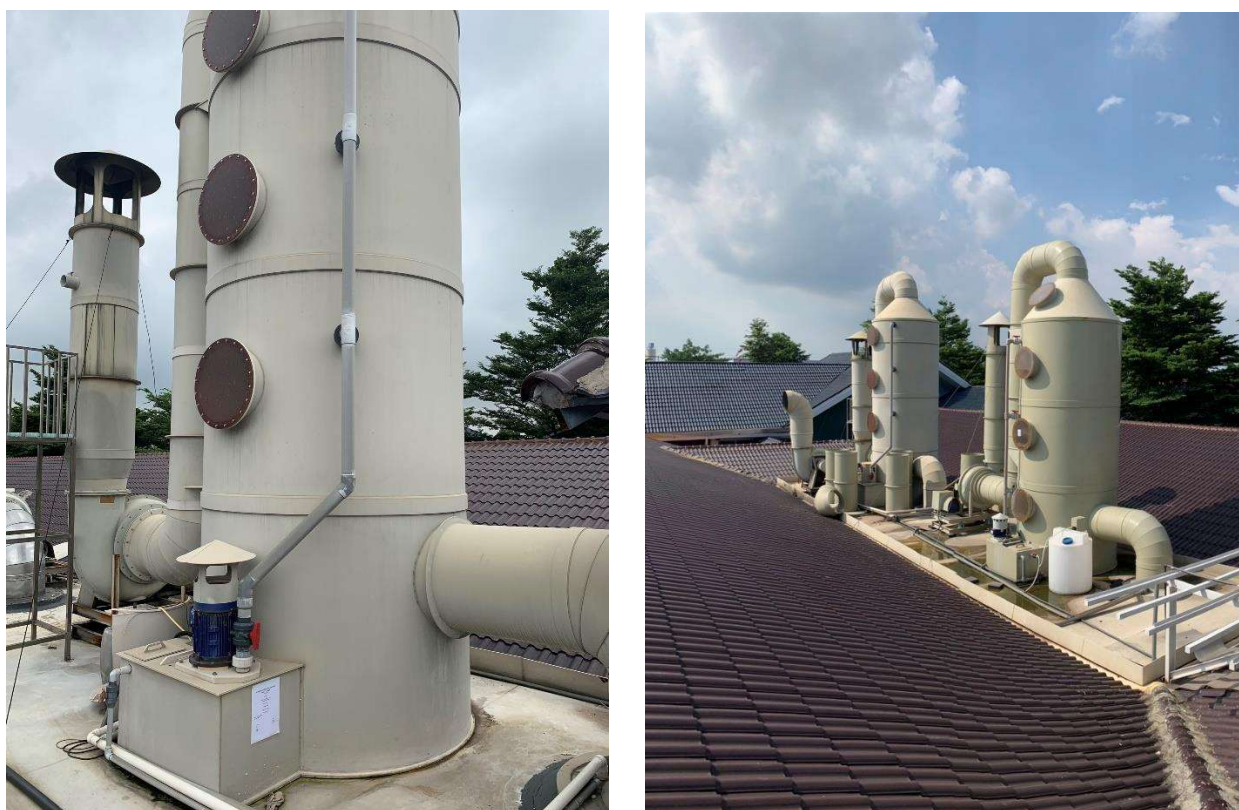
Hình 3.19: Hình ảnh HTXL khí thải hấp thụ bằng dung dịch NaOH
