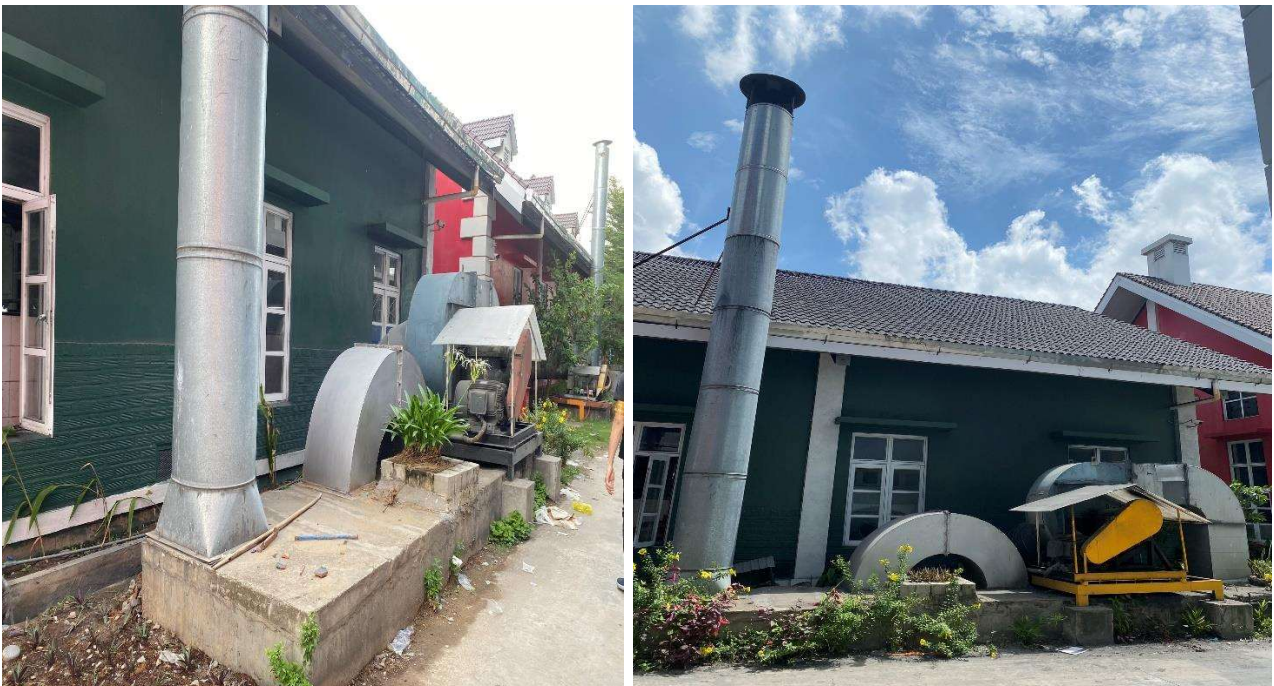
Hình 3.11: Hình ảnh HTXL khí thải từ quá trình mài bóng
