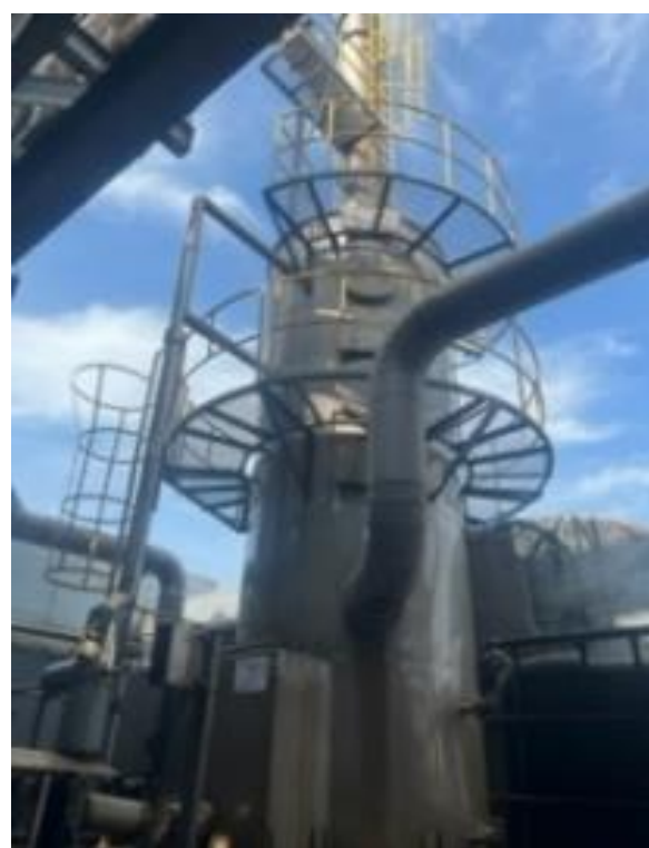
HTXL hơi hóa chất tại khu vực trùng hợp của xưởng Spandex
