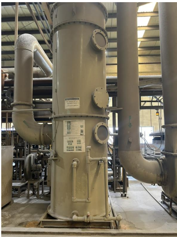
HTXL hơi hóa chất sợi viên 2, công suất 6.000 m 3 /h
