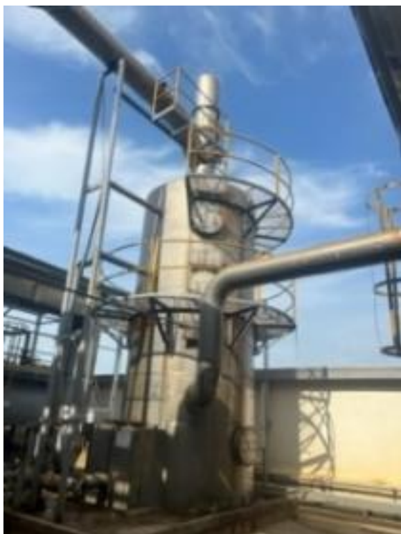
HTXL hơi hóa chất tại khu vực trùng hợp của xưởng Spandex
