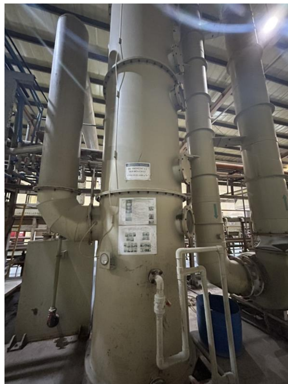
HTXL hơi hóa chất sợi viên 2, công suất 6.000 m 3 /h
