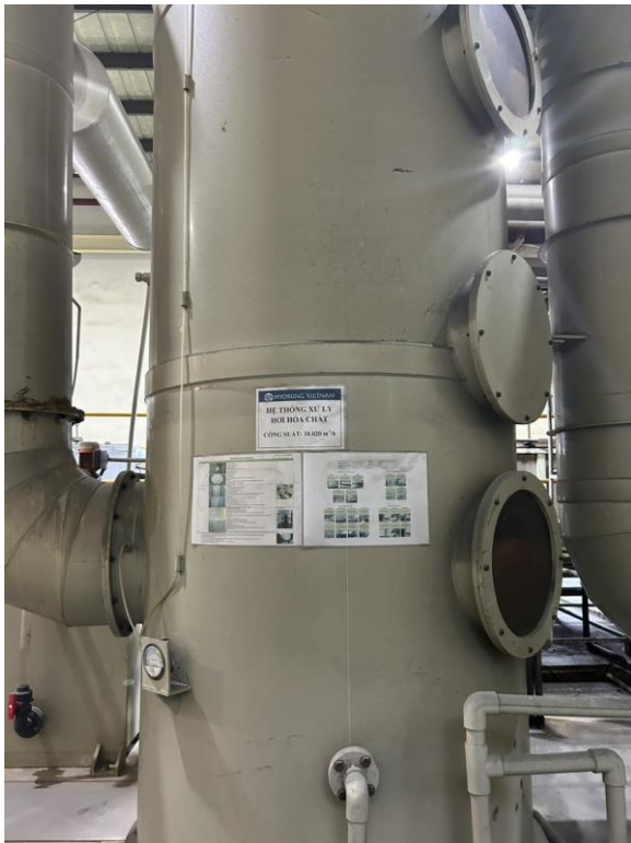
HTXL hơi hóa chất sợi viên 2, công suất 10.020 m 3 /h
